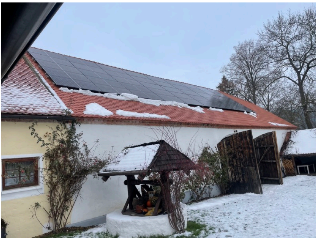
Instalace FV systému v počtu solárních panelů čtyřiceti pěti o výkonu 19,8 kWh
